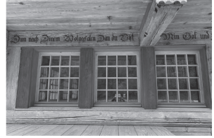
umbau haus in trueb
