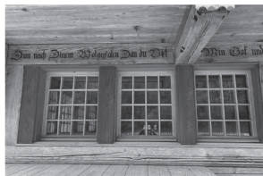
umbau haus in trueb
