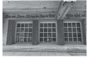
umbau haus in trueb
